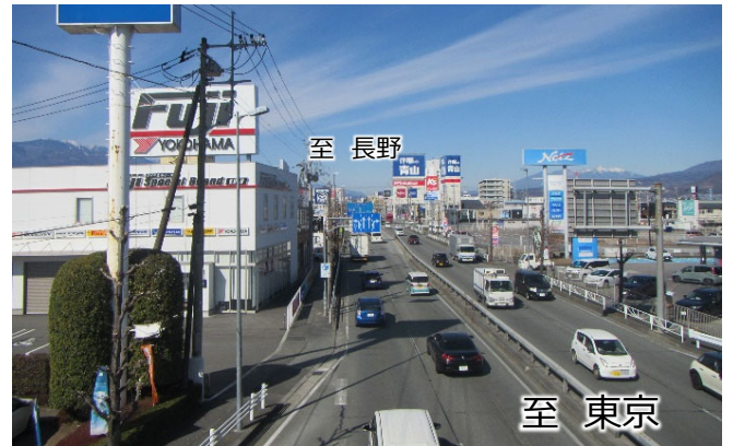
道路沿いの電柱・電線類 [令和5年2月撮影]
