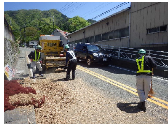
緊急対応状況(落下物処理)
