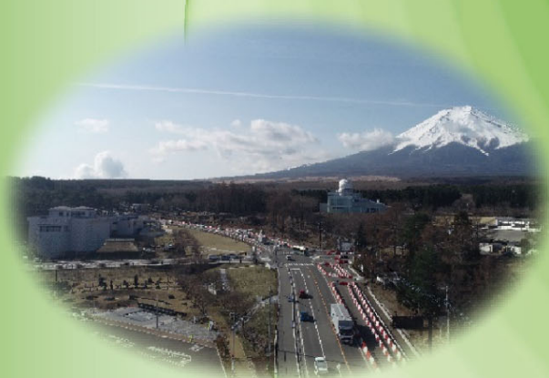
国道138号 新屋拡幅
