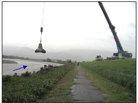
被災後、緊急対応として根固めブロックの設置を実施。
