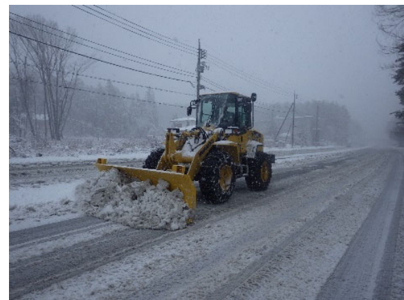
除雪作業状況
