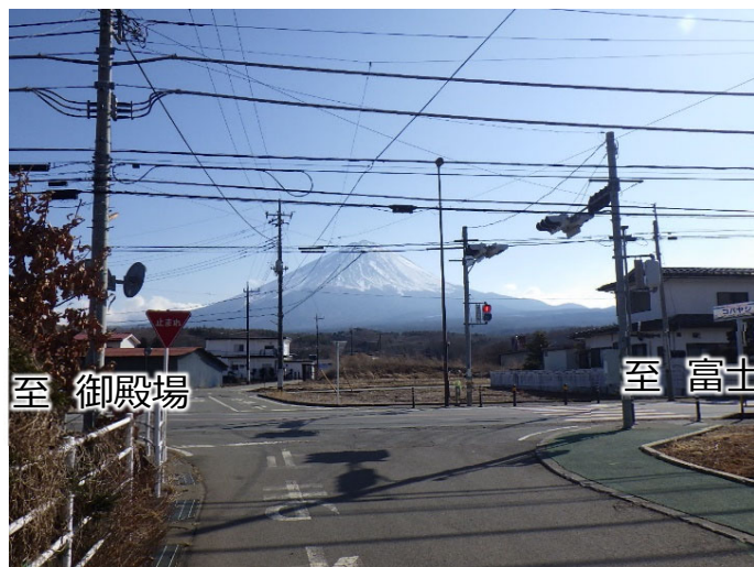
富士山の眺望を阻害する電柱電線類 [令和5年2月撮影]
