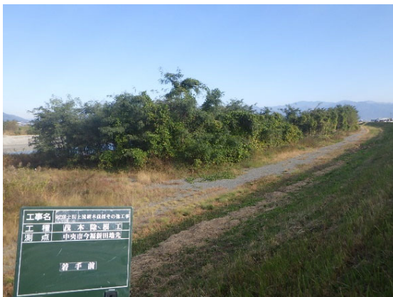
河道内に著しく繁茂した樹木により、洪水時に水が流れにくくなります。また、河川の状況の把握が出来なくなります。
