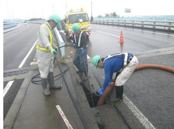
道路清掃作業状況
