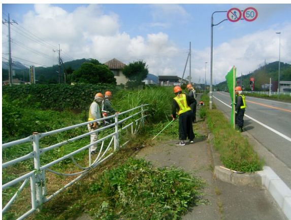
除草作業状況
