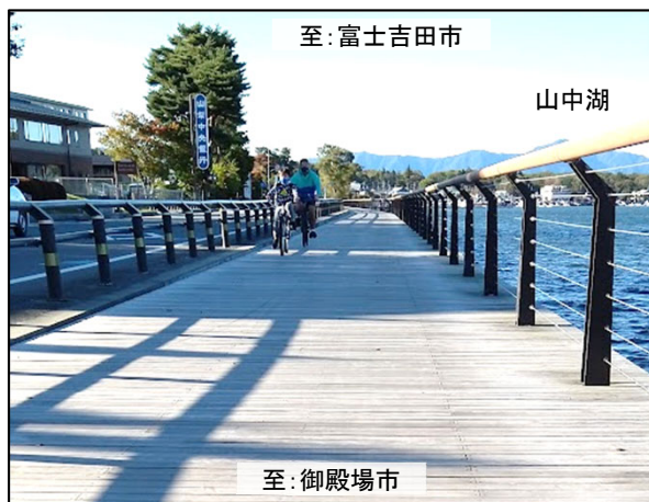
①整備済み区間 [2021年10月撮影]
