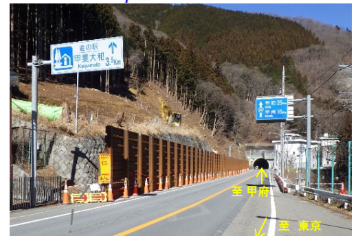
新笹子トンネル起点側工事状況 令和5年2月撮影
