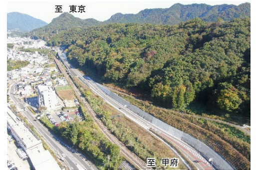
大月バイパス終点部付近 令和4年10月 (八王子方面を望む)
