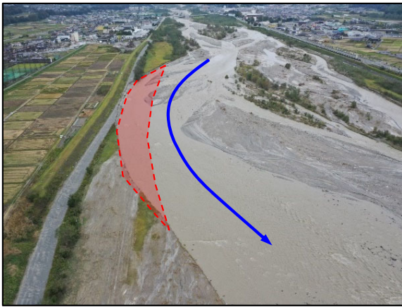
令和元年台風19号の出水の影響により 河岸侵食が発生。( にらさき しもじょうひがしわり 韮崎市下條東割地先)
