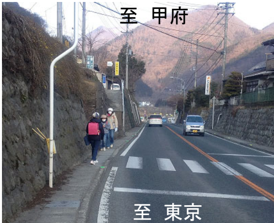
歩道未整備状況 [2014年3月撮影]
