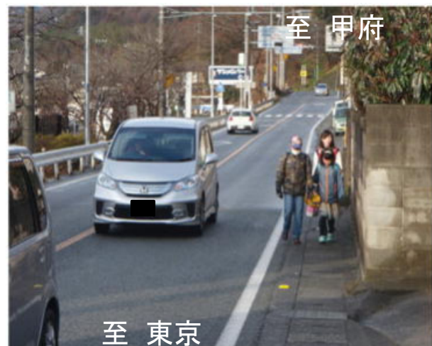
歩道未整備状況 [2015年3月撮影]
