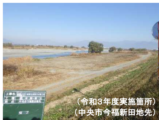
樹木伐採により、洪水を安全に流下させます。また、河川の状況の把握が容易に出来ます。
