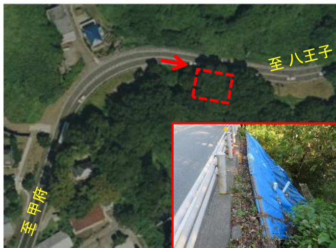
山梨県上野原市四方津地先 【防災対策】場所打法枠工等
