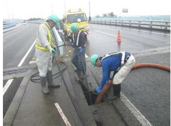
道路清掃作業状況
