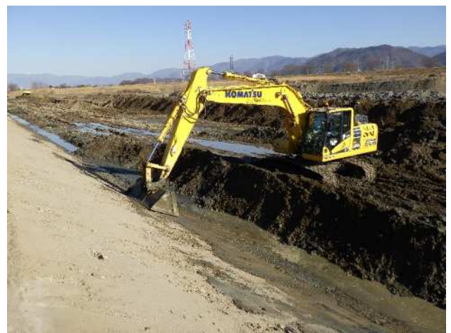
ICT建設機械による法面整形
