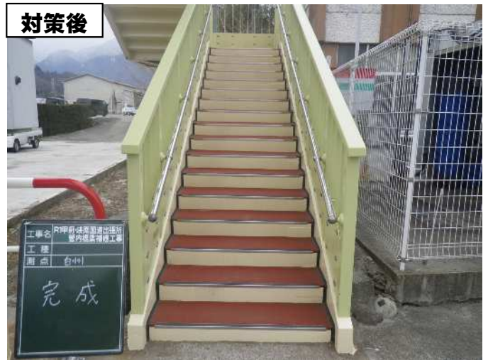
横断歩道橋の事例(階段部補修)
