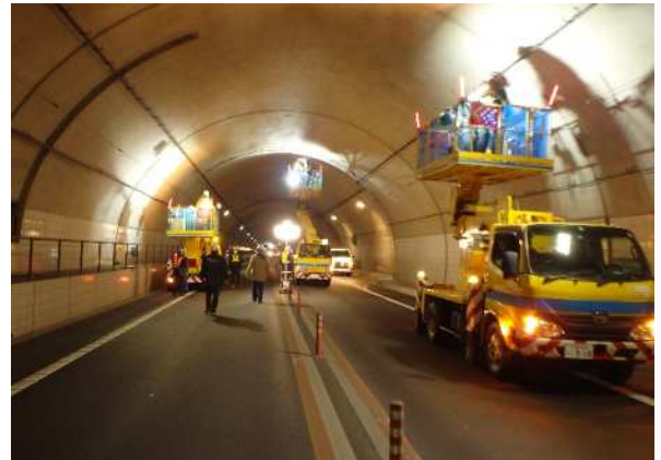
トンネル点検実施状況
