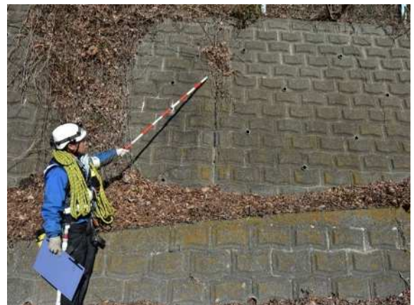
防災点検(ブロック積)実施状況
