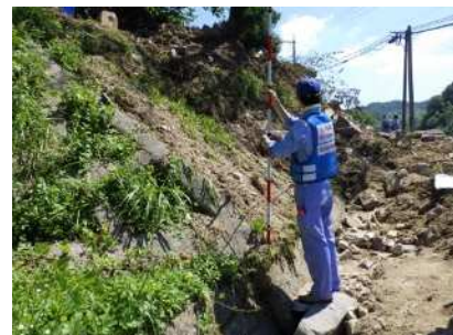
被災状況調査(土砂崩落)
