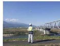
UAVによる起工測量
