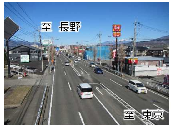
道路沿いの電柱・電線類 [令和3年3月撮影]
