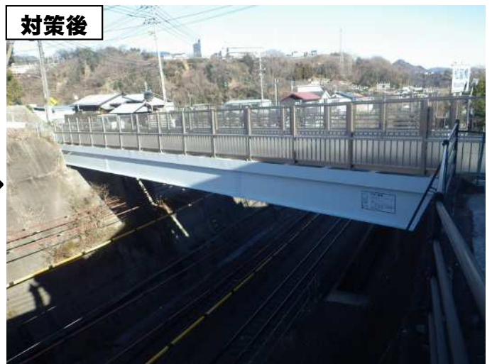
橋梁補修の事例(高欄補修、桁塗装)
