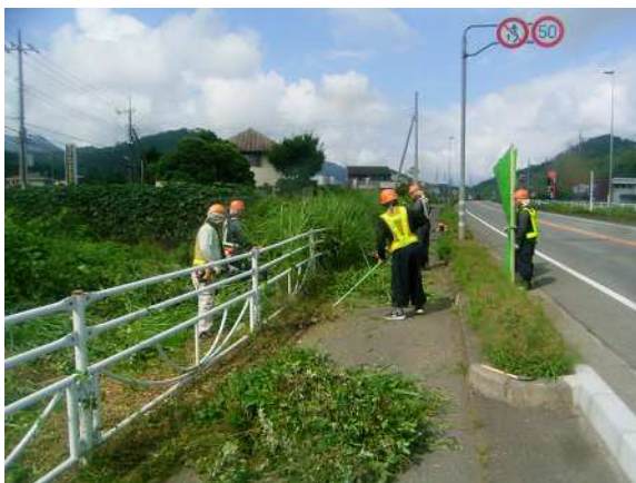
除草作業状況
