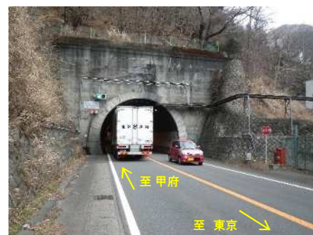
【新笹子トンネルの交通状況】 令和4年3月撮影
