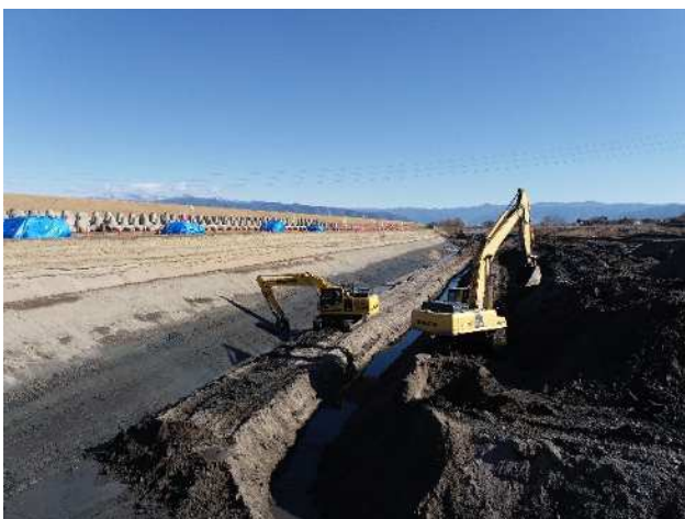
ICT建設機械による掘削
