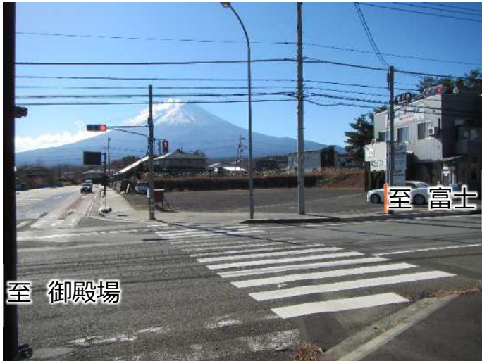
富士山の眺望を阻害する電柱電線類 [令和3年11月撮影]
