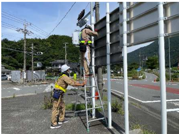
道路附属物点検実施状況
