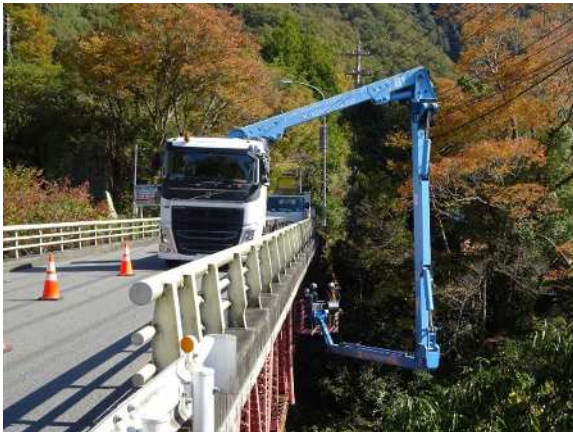
橋梁点検実施状況
