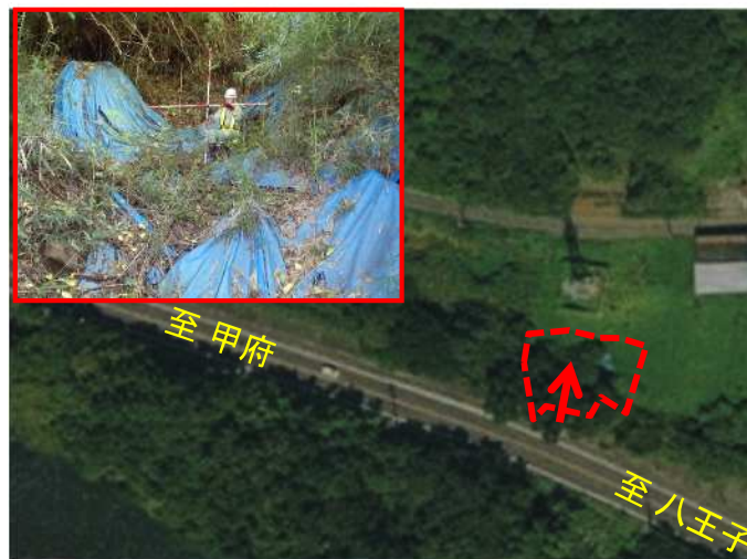
山梨県上野原市松留地先 【防災対策】吹付法枠工等
