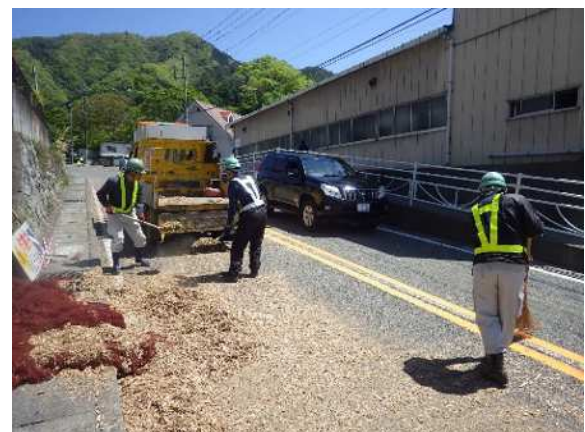
緊急対応状況(落下物処理)
