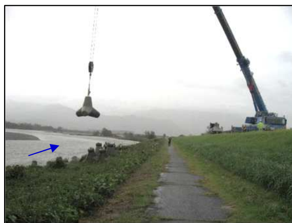
被災後、緊急対応として根固めブロックの設置を実施。
