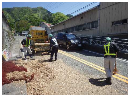
緊急対応状況(落下物処理)
