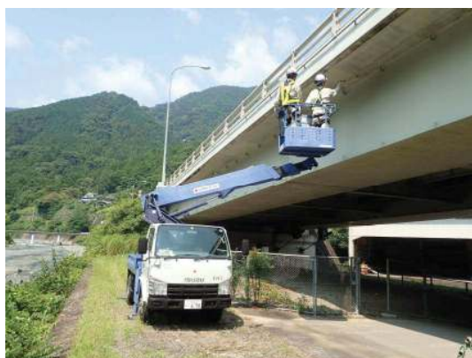
橋梁点検実施状況
