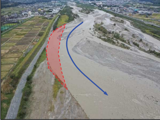
令和元年台風19号の出水の影響により にらさきしもしょうひがしわり 河岸侵食が発生。(韮崎市下條東割地先)
