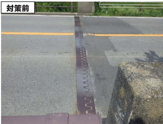
橋梁補修の事例(伸縮装置取替工)
