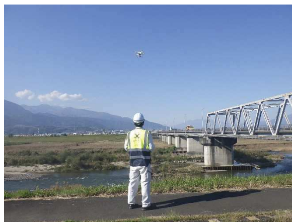
UAVによる起工測量
