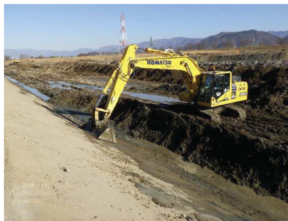
ICT建設機械による法面整形
