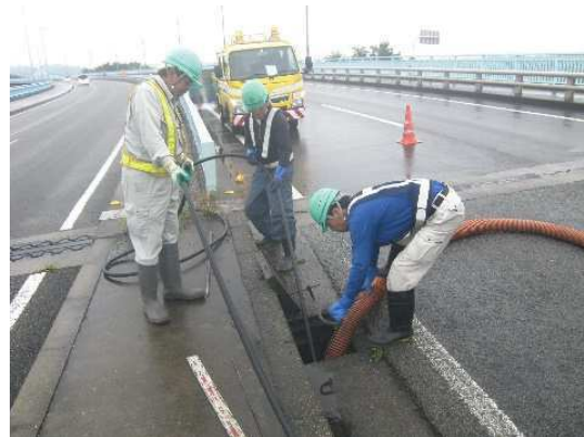
道路清掃作業状況
