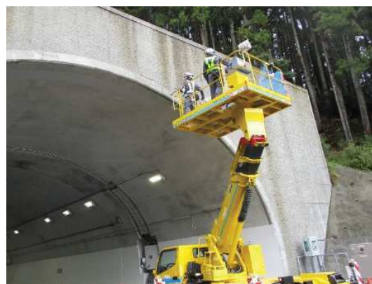
トンネル点検実施状況
