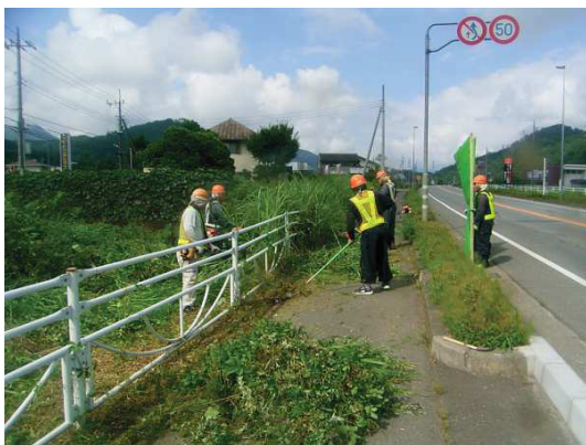
除草作業状況
