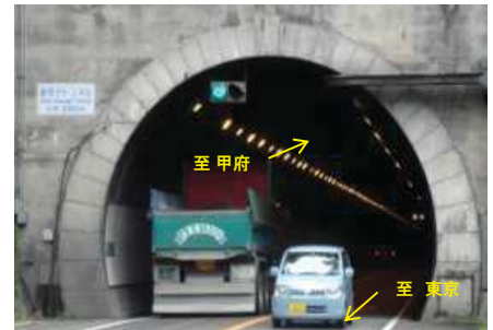
【新笹子トンネルの交通状況】 平成25年8月撮影
