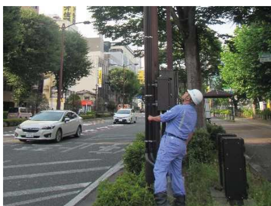
道路附属物点検実施状況
