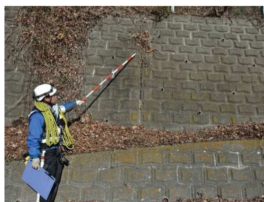
防災点検(ブロック積)実施状況
