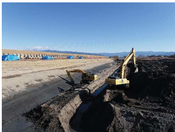
ICT建設機械による掘削
