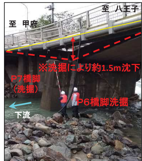
■ 被災状況写真
