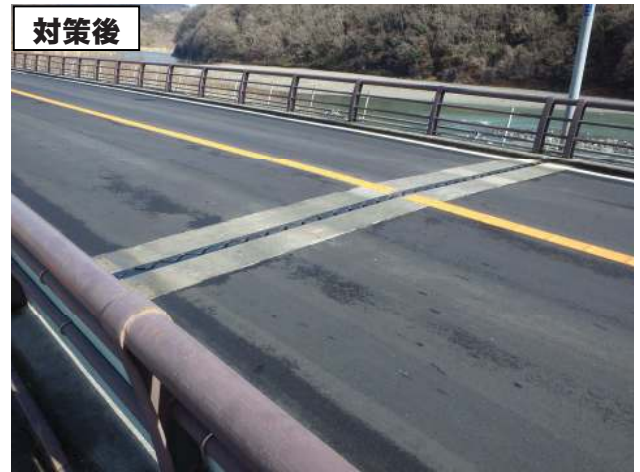
橋梁補修の事例(伸縮装置取替工)
