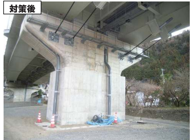
橋梁耐震補強の事例(橋脚巻立て、落橋防止)
