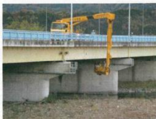
▲橋梁点検実施状況
