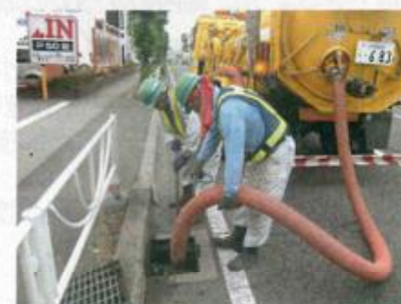
▲道路清掃作業状況
