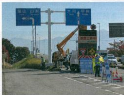
▲道路附属物点検実施状況
