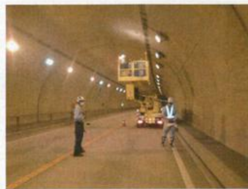
▲トンネル点検実施状況
