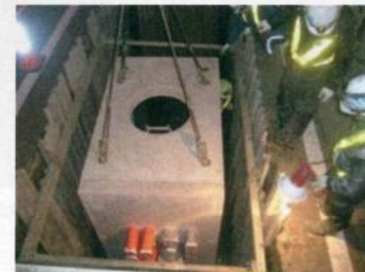
電線共同溝の設置状況
