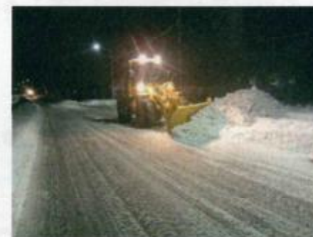
▲除雪作業状況
