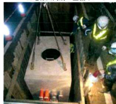
▲電線共同溝の設置状況
