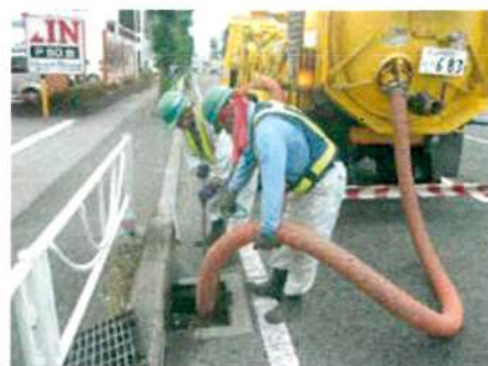
▲道路清掃作業状況
