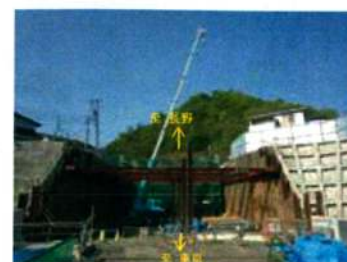
花咲地区函渠の施工状況(甲府方面を望む) 【撮影:平成30年4月】
