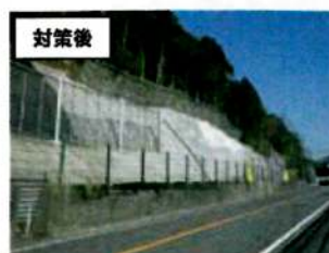
▲防災対策の事例(のり面の落石防護柵, 吹付枠)
