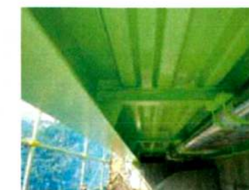
▲橋梁補修事例(塗替塗装)
