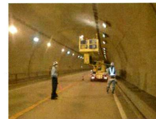
▲トンネル点検実施状況
