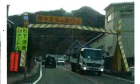
▲高さ制限ゲート 【平成26年5月撮影】
