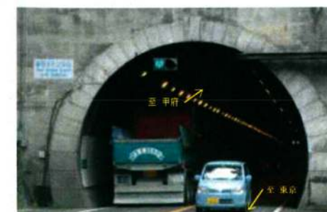
▲新笹子トンネルの交通状況 【平成25年8月撮影】
