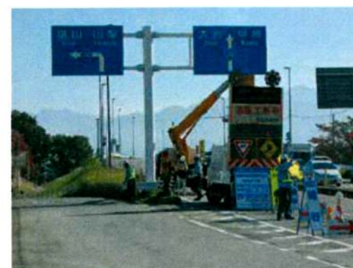
▲道路附属物点検実施状況
