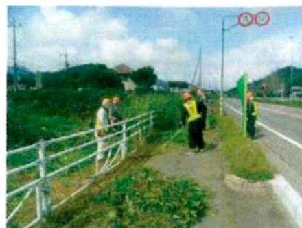
▲除草作業状況
