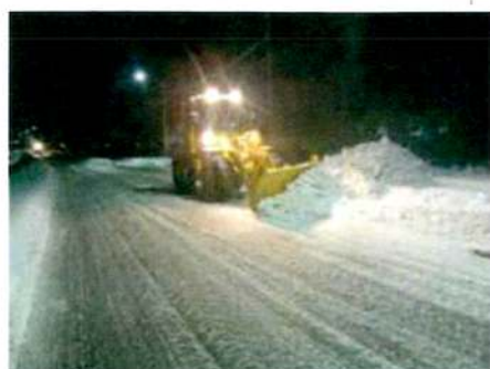
▲除雪作業状況
