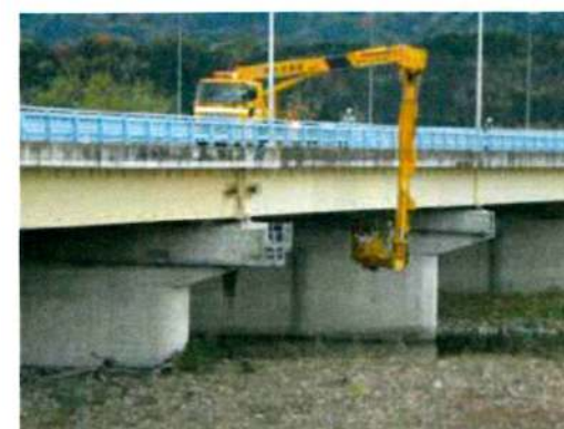
▲橋梁点検実施状況
