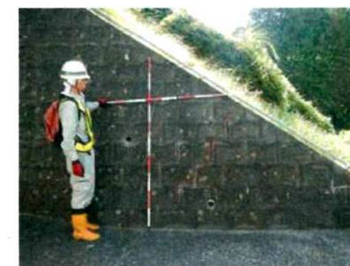
▲防災点検(のり面)実施状況
